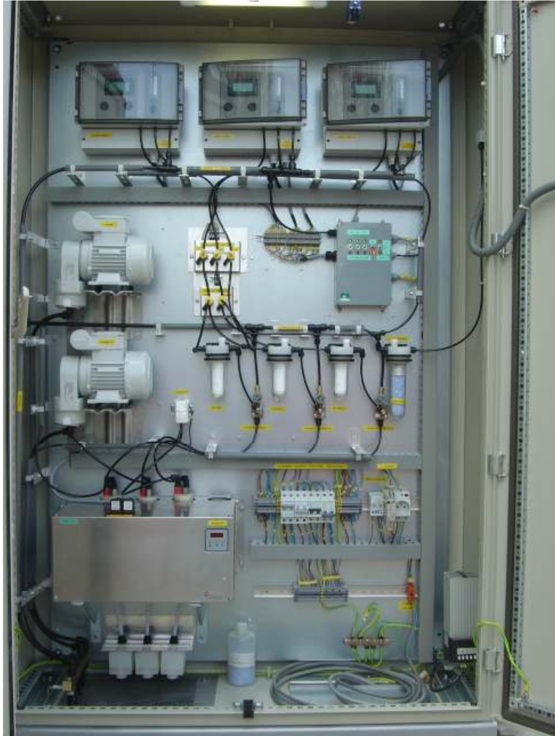
Système d'analyse de CH 4 et H 2 S Avec conditionnement du gaz
