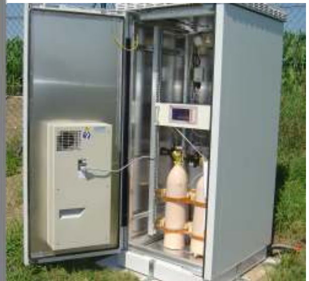
Analyse de CH 4 ambiant Basé sur un analyseur MGA3000 CH 4 ambiant en trace Armoire intérieure et extérieure avec échantillonnage Et conditionnement de température
