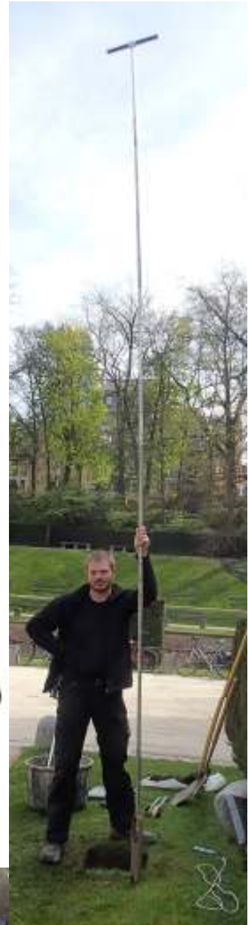
Creusement et installation de Piézomètres
