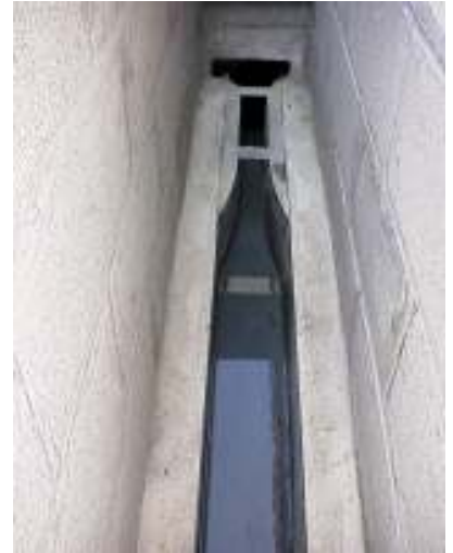
Canal Venturi En Inox ou polyester Avec/sans chambre latérale
